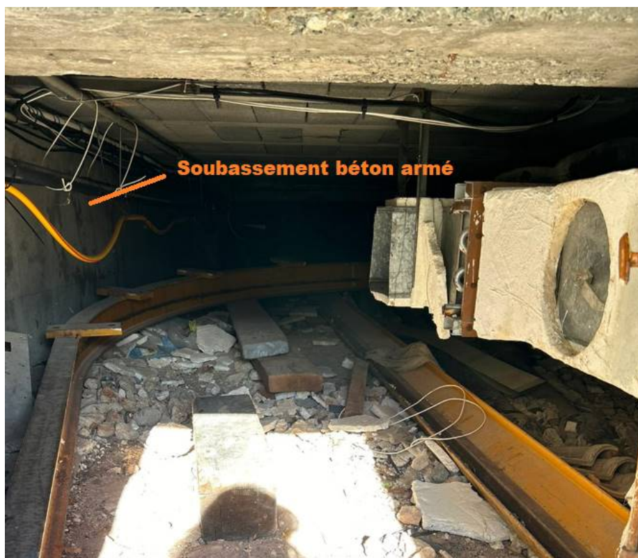
Figure 20 : Présence de soubassements linéaires BA en vide sanitaire
