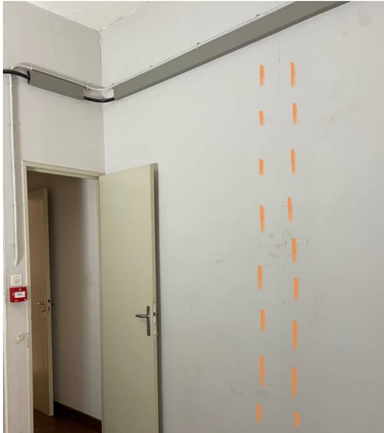
Figure 21: Sondage sur pilier périphérique en façade
