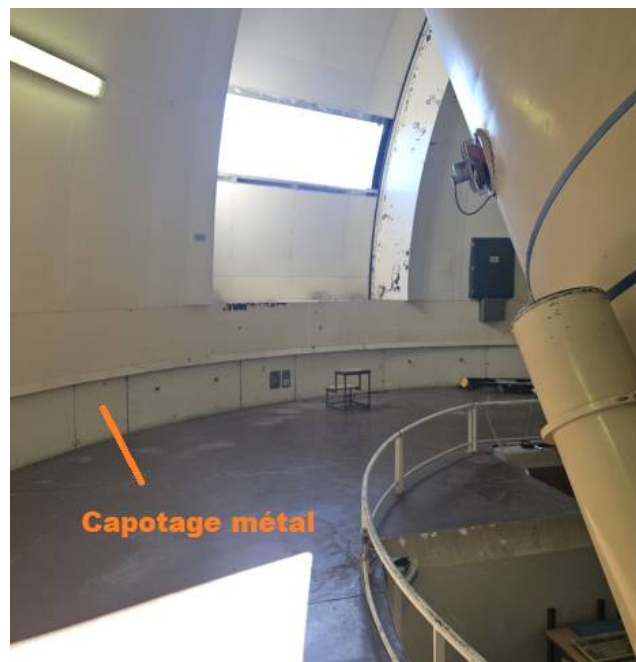
Figure 25 : Photo de la jonction basse coupole / dalle béton
