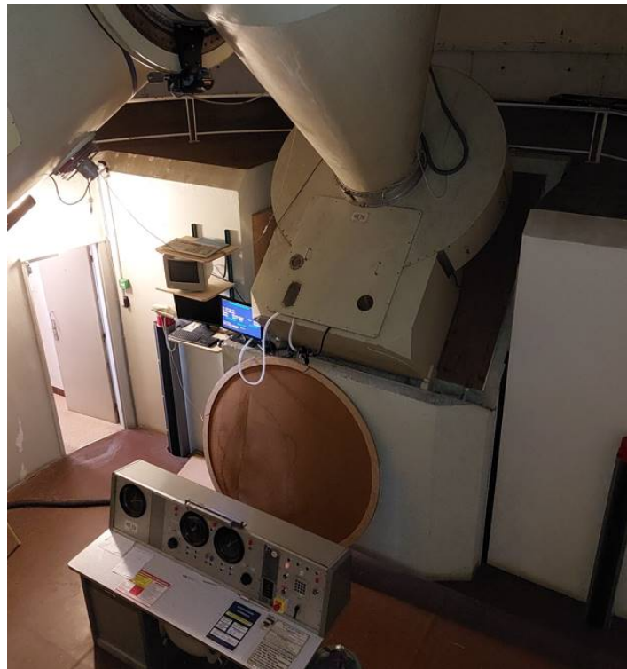
Figure 31: Plancher mobile pour maintenance du miroir principal
